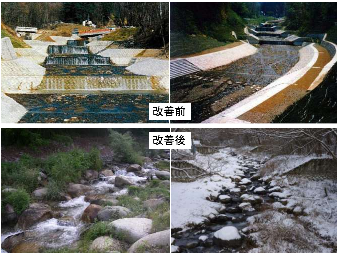
図4 長野県牛伏側の改修事例
