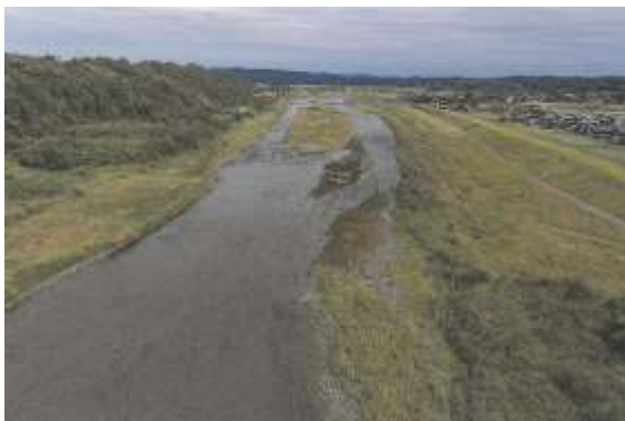
図6 小川地区施工箇所その1
