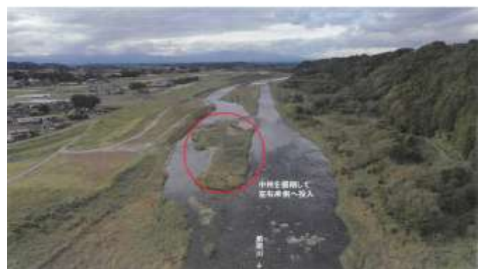
図7 小川地区施工箇所その2
