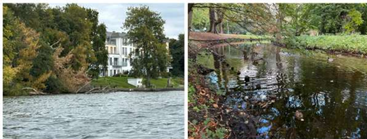
図3. ベルリン市内の近自然工法による再生事例. 倒木を活用し護岸保護と魚類ハビタット造成の両立が図られている.
