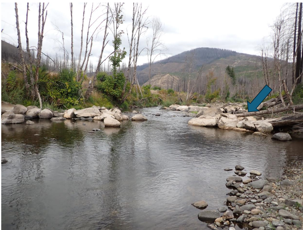
図1. オレゴン州を流れる North Ampqua River の支流、Rock Creek につくられた巨石と焼き枯れた樹木を組み合わせで作られたバンプ工.
