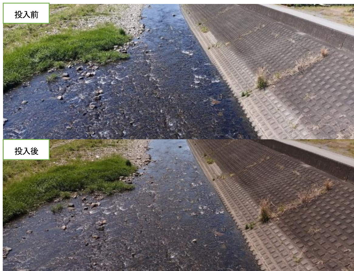
図 4. 巨石投入前後の流況の変化.
