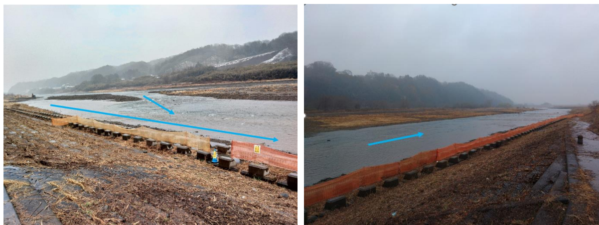
図6 工事完了直後（3月5日）の様子
