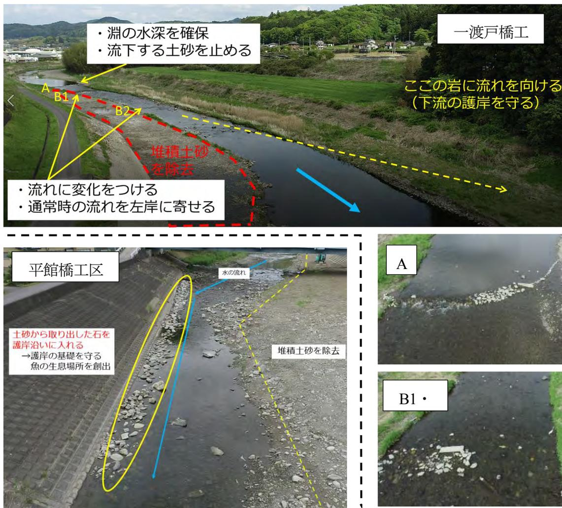
図 13 堆積土除去工事で発生した巨石を活用した水制工
