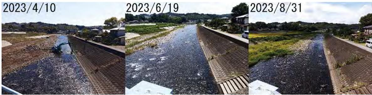
図 12 平館橋下流の工事前と工事後の瀬頭付近の流況の変化
