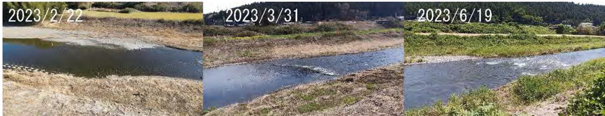
図 10 水制工①の工事前と工事後の瀬頭付近の流況の変化
